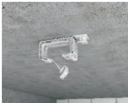
Montering i taket Grip-klammern är fastsatt i taket.
