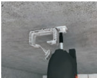
Montering i taket med spikpistol Kabeluppsamlarens fästelement kan placeras på den gasdrivna spikpistolens huvud och fixeras automatiskt genom särskilda lameller. Fastsättningen sker utan ytterligare hjälpmedel direkt på väggen eller i taket med hjälp av den spikpistolen.
