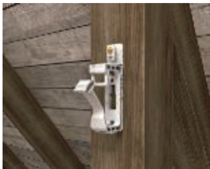
Fastsättning med spritskruv Kabelklammer fäst på en träbalk.
