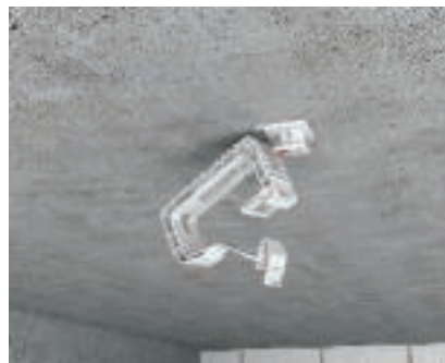
Fastsättning av kabelklammer Separera fästelementet från Grip-klammerna med en drag-vridrörelse.
