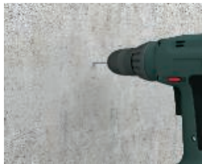
Monteringsförberedelse för fastsättning med spikplugg Skapa 6-mm-borrhål.
