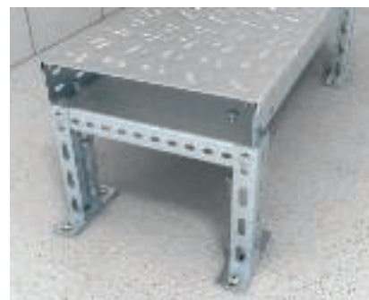
Konsolkonstruktion Installation och fastsättning vid golvkonstruktion.
