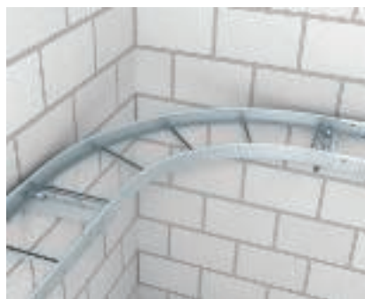
Installation av en böj. Förbindning av kabelstegen med böjen av typen LBI 90. I detta område ska ytterligare konsol användas.
