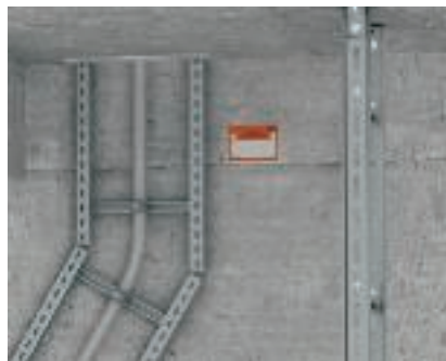
Riktningssändring Utförande av avvinkling tung stigare av typen SLM.
