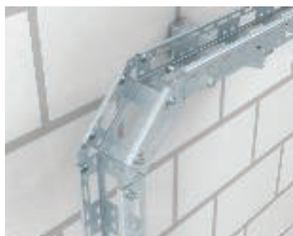
Vertikalböj 90°, nedåtgående Installation med skarvförbindningar typ SV.
