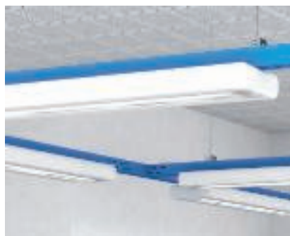
Armaturredna Upphängning av armaturredna med mittupphängning MAH och gängstång.
