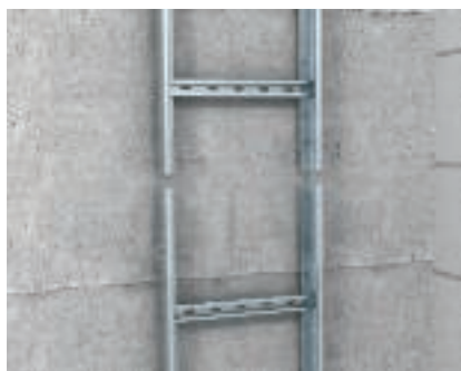
Skarvförbindning av stigare Förbindning av stigare av typen LG och SSL 60 med förbindning av typen LVG.
