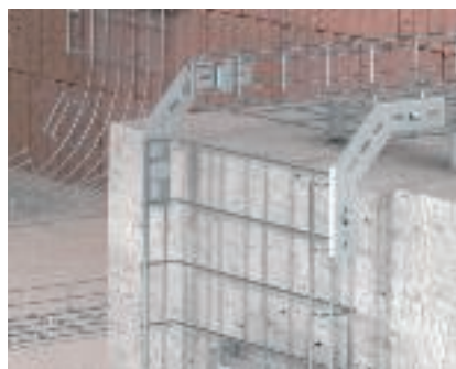
Konsolkonstruktion med vertikalbøj Installation av en vertikalbøj med monteringsvinkel typ MW på konsolmonterade C-trådsteigar.
