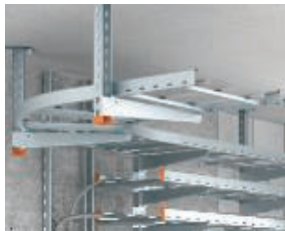
Färdig montering Kabelstegsmontering.
