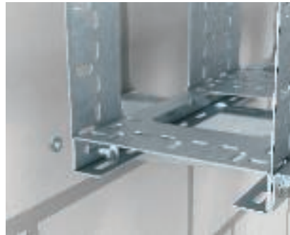
Installation bottenprofil Installation av profilen i BKK-systemet.
