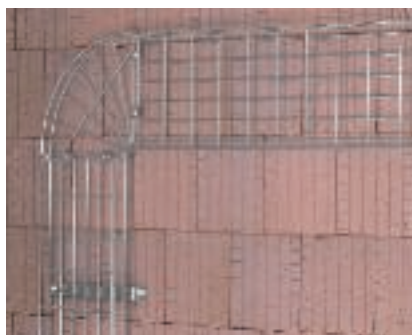
Vägginstallation Vägginstallation av C-trådsteigar och böjar 90°.
