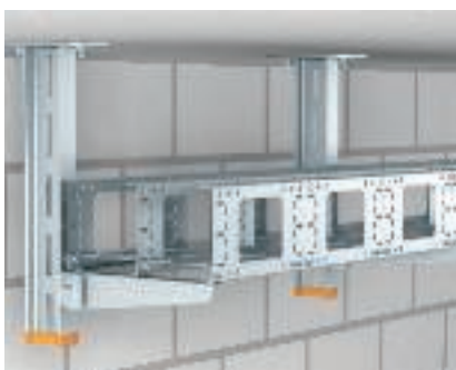
Färdig montering Färdig byggsatsmontering.
