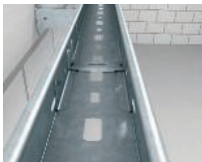
Skarvförbindning Horisontell skarvförbindning av armaturskena av typen LTR med skarvförbindningsset av typen RV 607.
