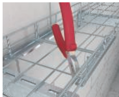
Skruvlös skarvförbindning med snabbförbindning Upprättande av en skruvlös skarvförbindning för trådstegar med hjälp av en snabbförbindning typ GRV.
