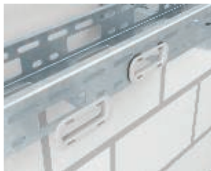
Kabelskydd i sidogavel Insättning av kabelskydd typ KSR-910 i sidogaveln.
