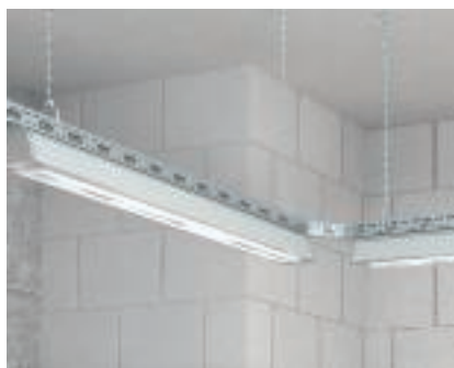
Armaturskenor Upphängning av armaturskena med kedja och upphängningsbygel.
