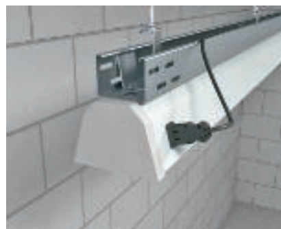
Enkel armaturinstallation Montering av förkopplade lampor under en armaturskena.
