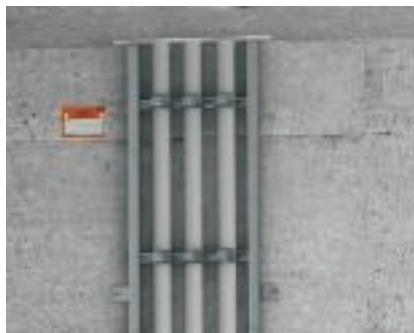
Väggmontering Vägginstallation av en lätt stigare med fästvinklar.
