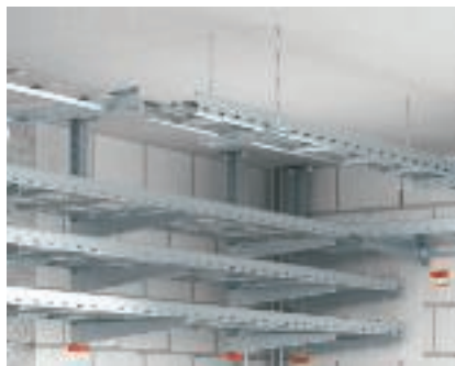
Takpendel- och gängstångsupphängning. Exempel på installation av kabelstegar med takpendlar av U-pendlar och gängstångsupphängning.
