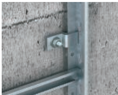
Väggfäste lätt utförande Väggmontering av lätt stigare av typen SLL 45 med väggkonsol av typen WB 30/75.
