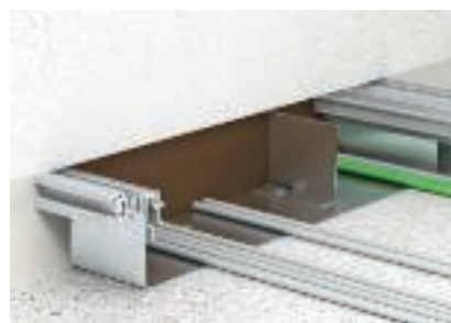
Tomrör med dragledning kan skummas vid efterinstallation
