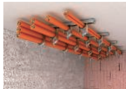
Vågrät installation av kablar med kabelhållare under taket
