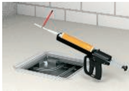
Användning av blandröret med förlängning för att pressa in brandskyddsskummet
