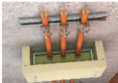
Installation av dragavlastningen i kombination med kabeldragning på profilskenor
