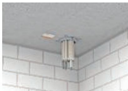
Installation på takets undersida med metallpluggar
