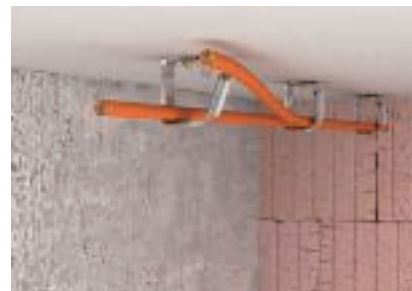
Enkel inläggning av kablarna i det öppnade mångkabelfästet
