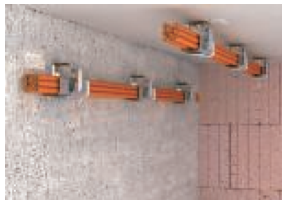
Installation av mångkabelfästet 2031 M 15 med långgavel
