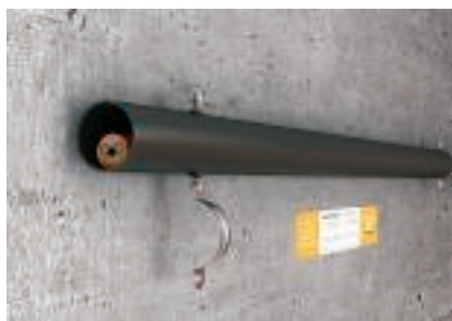
Inläggning i skruvavståndshållaren genom ihakning av överdelen under skruven
