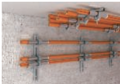
Vågrät installation med kabelhållare och långgavlar på väggen och under taket
