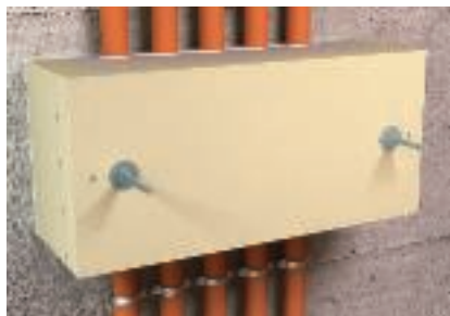
Installation av dragavlastningen i kombination med enkelhållardragning
