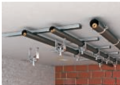
Takinstallation med skruvavståndshållare och kabelhållare
