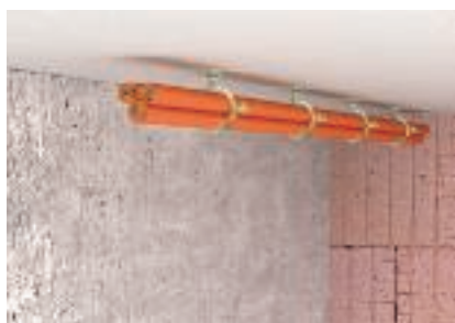
Ihobuntad kabeldragning under taket
