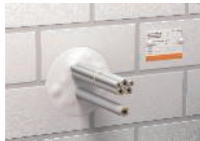
Märkning av små tätningar
