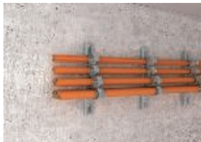
Vågrät installation av kablar med kabelhållare på väggen
