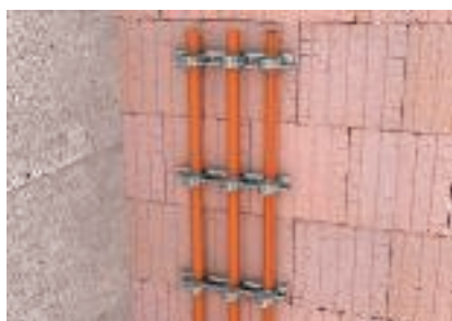
Lodrat installation av kablar med kabelhållare på väggen
