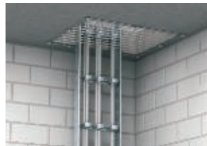
Säkring mot fall vid takinstallation
