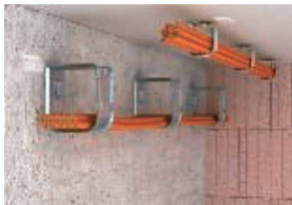
Vågrät vägg- och takinstallation
