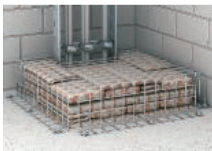
Säkring mot rutschning ovanför golvet
