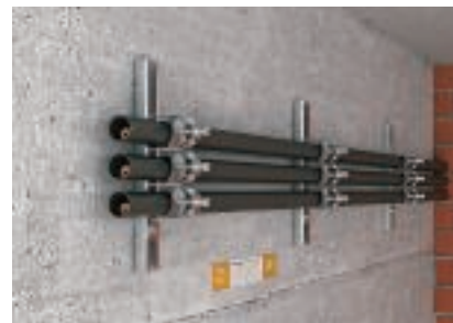
Utrymmesnål installation av flera rör bredvid varandra med kabelhållare
