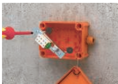
Installation med brandskyddsexpander genom FireBoxens bygel och golv
