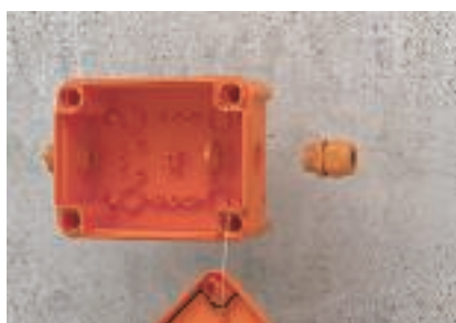
Kabelinföring med V-TEC-kabelförskruvningar
