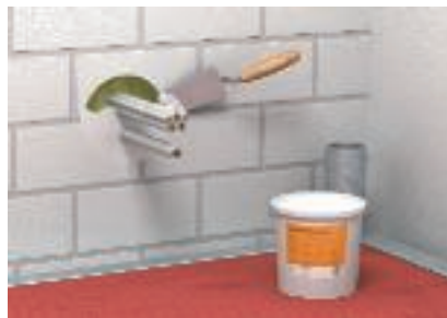
2 cm djup dubbelsidig förslutning av ytorna med isoleringslagerbildaren DSX
