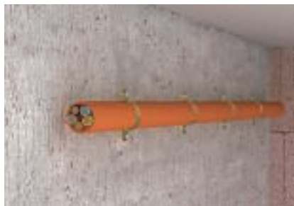
Vågrät installation av kablarna på väggen
