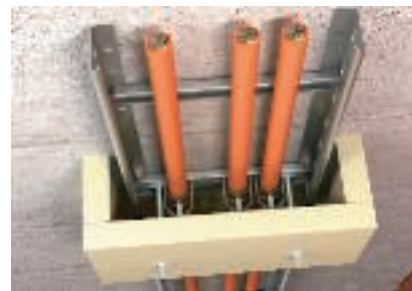
Installation av dragavlastningen i kombination med stigare
