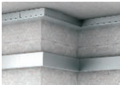
Vågrät vägg- och takinstallation
