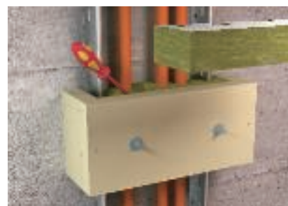
Fyllning med mineralull för flexibel kabelbeläggning
