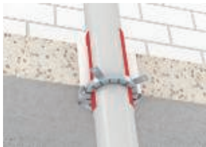
Installation på takets undersida med metallpluggar
